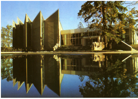
Pedrangu tarybinio ūkio administracinis pastatas, architektė Mara Metsal, 1977–1982 m.
